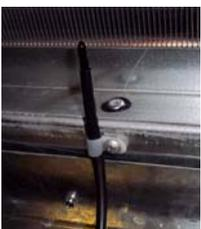
Fijar este sensor usando la abrazadera de plástico suministrada. Debe estar ubicado antes de la DX-Coil después de pre-acondicionamiento (Mezcla de aire a aire Intercambiador de calor / aire de retorno / Calefacción auxiliar o de refrigeración). Asegúrese de que la punta del sensor de resina no esté cubierta por el tubo de vinilo protector.
